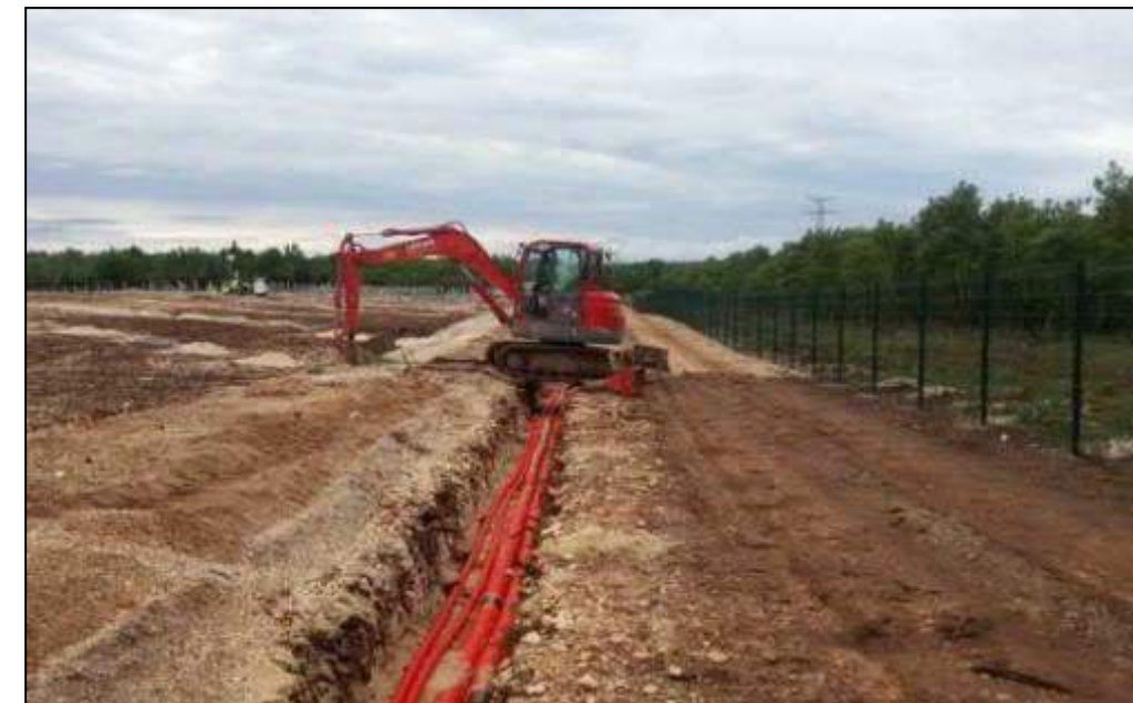
Enfouissement des réseaux (photo exemple)
