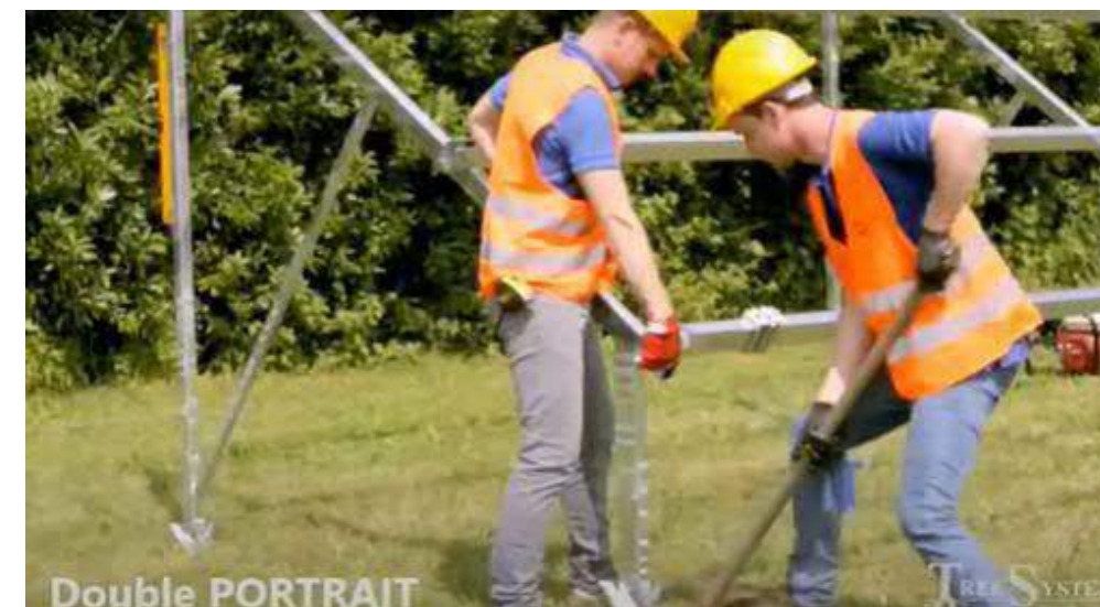
Creusement d'un trou du sol de quelques centimètres à la main
