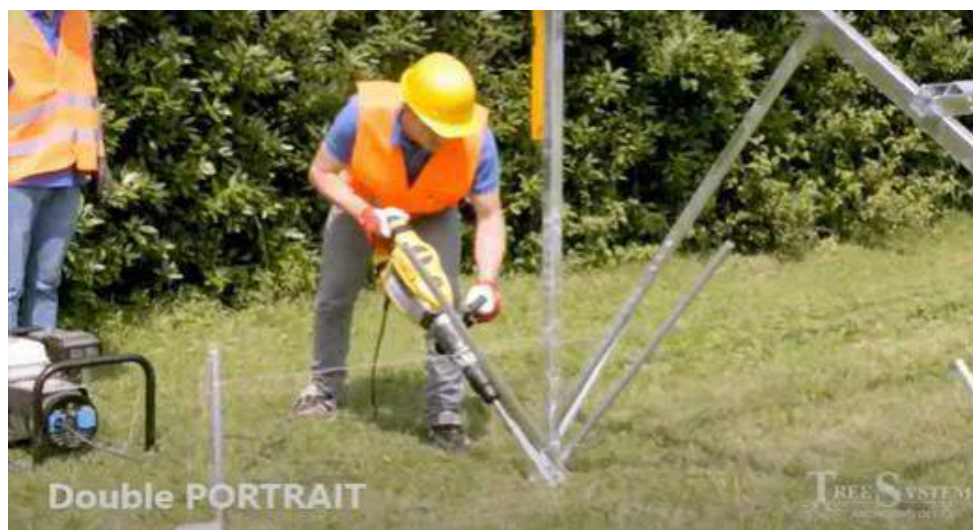
Poussage des tuyaux dans le sol à l'aide d'un marteau électropneumatique
