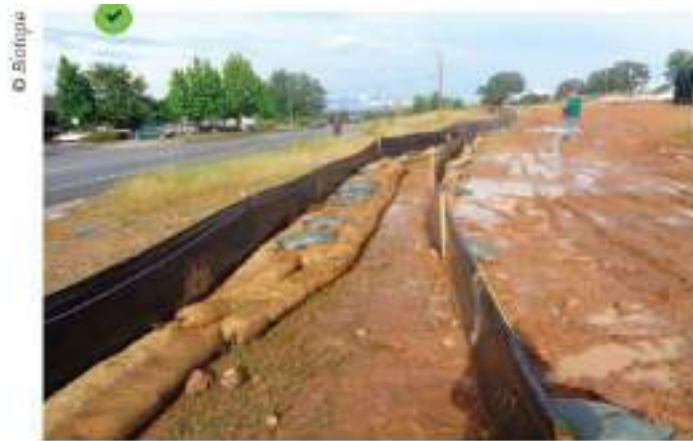
Double barrières de rétention installées à la périphérie de l'emprise du chantier et conjuguées à des boudins en fibres de paille maintenus au sol par des sacs de graviers.
