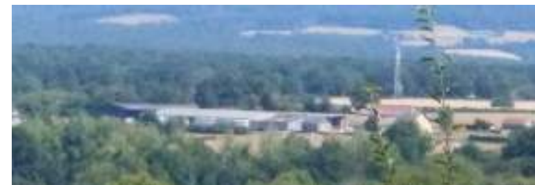
Grands bâtiments agricoles dans la vallée de l'Aron
