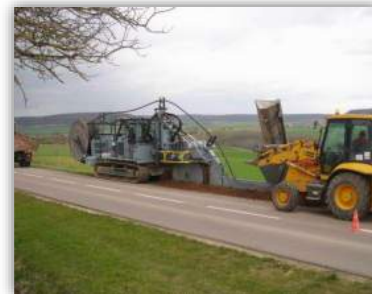
Réalisation de la tranchée (photo exemple)
