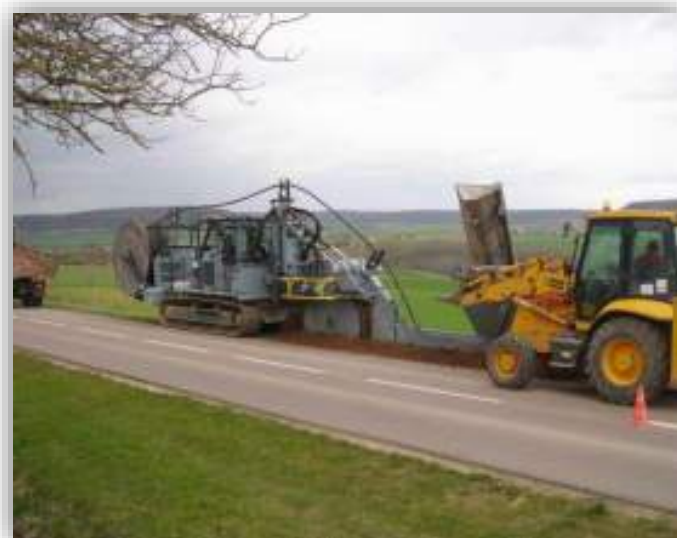
Réalisation de la tranchée (photo exemple)
