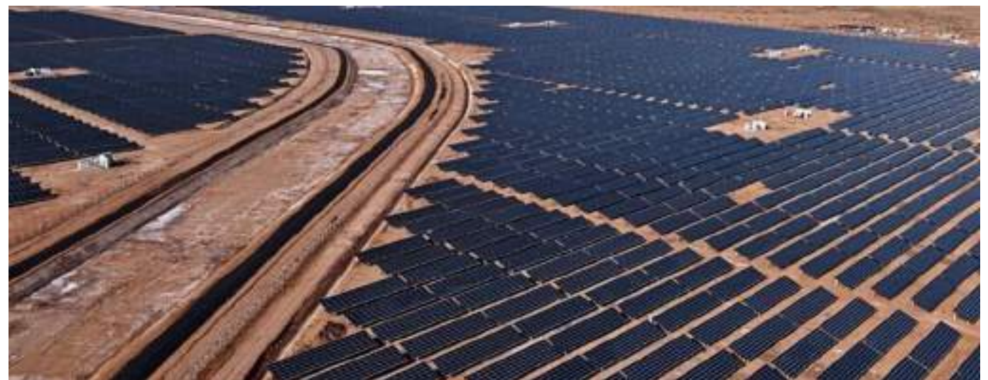
Centrale photovoltaïque au sol de Kamuthi, Inde
