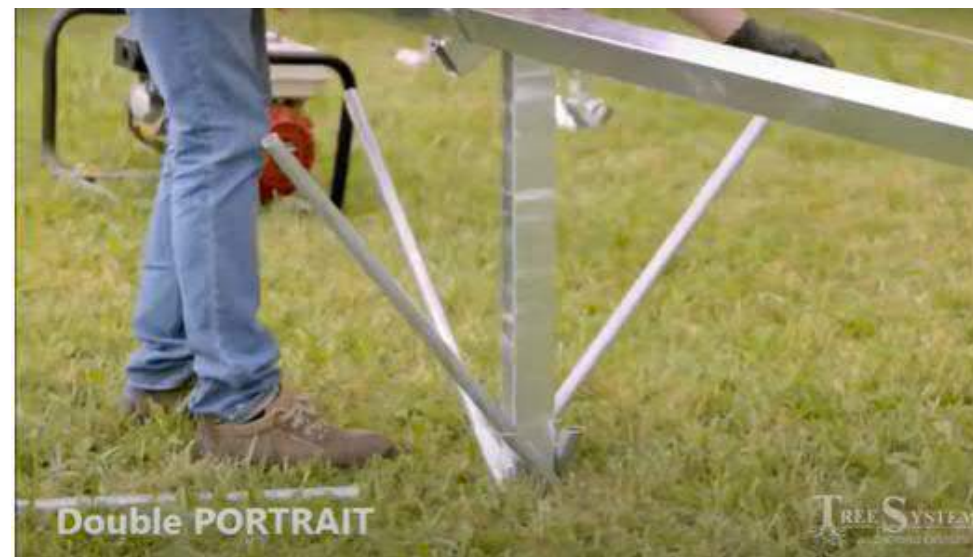
Pose des tuyaux obliques dans les chevilles
