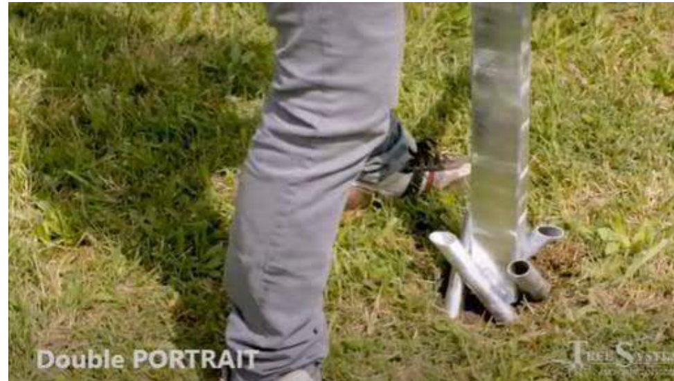
Pose de la structure dans un trou du sol de quelques centimètres
